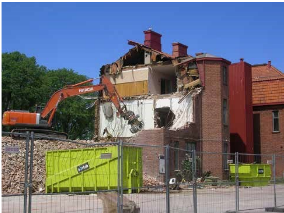
Rivning av Hemgårdsbyggnaden på Pottholmen
