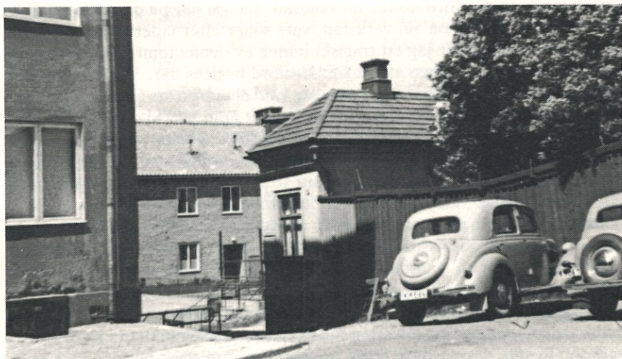
Gaveln av huset västra sidan av kv Cronhaven.
