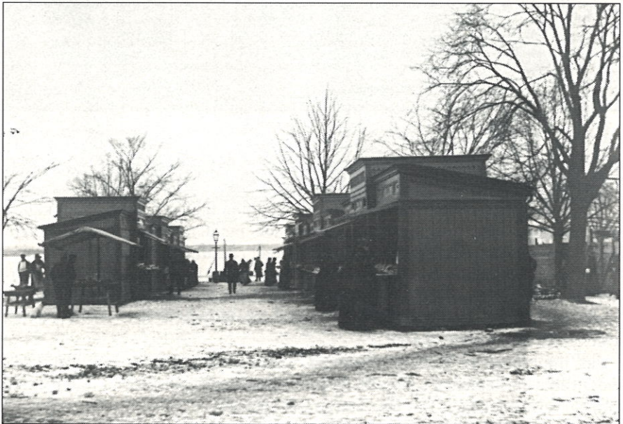
En vintrig bild från fiskbron, med kommersen vid köttbodarna – innan saluhallen byggdes.
