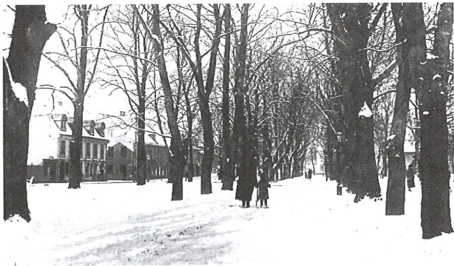
Vintrig bild från västra delen mot Landbrogatan, där förr Landbron fortsatte och utgjorde in- utfart åt Trossö.
