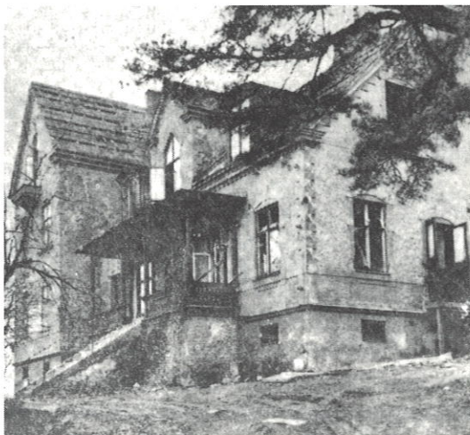
Flickhemmet på Sunnavägen, (vid Blå Port) strax före rivning.
