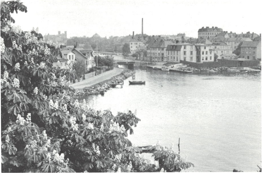
Lilla Holm i slutet av 40-talet. Transformatorstationen finns kvar, och är det lilla huset bredvid.
