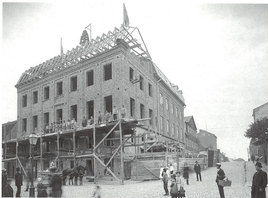
Uppförandet av Hantverkaregatan 11. Förmodligen är bilden tagen vid taklagsfesten – flaggan är i topp och en granrisgirland på taknocken som markerar att byggmästaren bjudit byggarna på fest!
