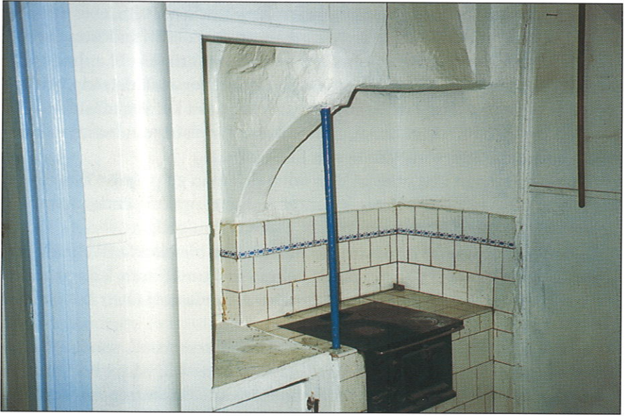
Interiör i ett av de gamla köken på bottenvåningen i stora huset åt gatan. För matlagning användes då järnspis, som var kombinerad med bakugn, samt spiskåpa för vädring.
