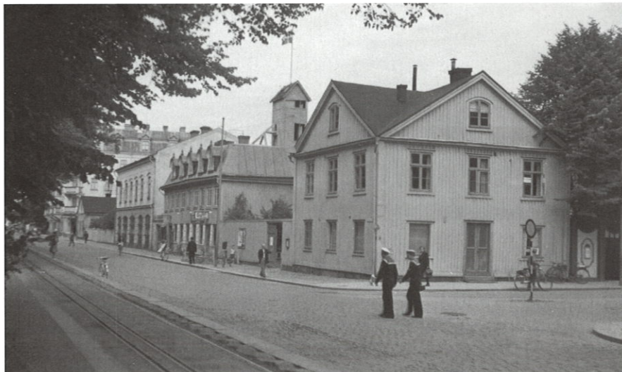
Brandstationen med tornet.
