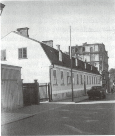
Tobaksmonopolets byggnad mot Ö. Köpmansgatan Kv. Adlersten. (foto Olle Olsson)
