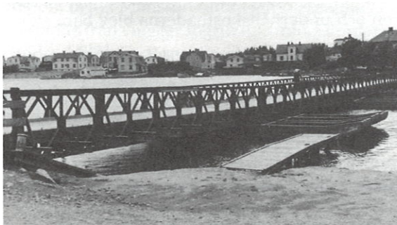
Pontonbron byggd av Ing. 2 på 6 timmar 1951.
