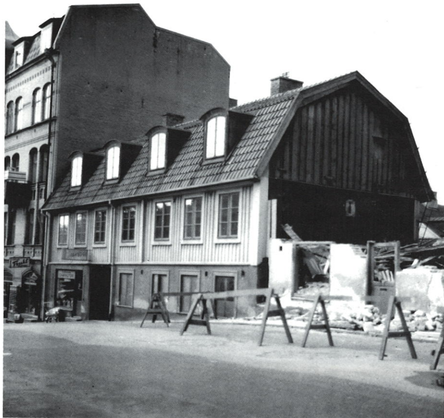
Här rivningen i full gång 1965, och på Konstapelsgatans backe väntar fastigheten med Karl Lundqvists charkuteri på grävskoporna. Foto BLM arkiv
