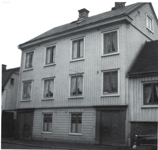
Västra Prinsgatan nr 13 - 15. Bilderna är tagna strax innan rivningen. Foto BLM arkiv
