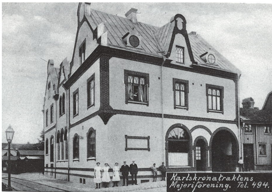
Karlskrona Mejeriförenings nybyggnad 1908 på Norra Smedjegatan 52, som inköptes av skorstensfejarmästare Holger Carlsson 1960. Vykort från Göran Mårtenssons arkiv.
