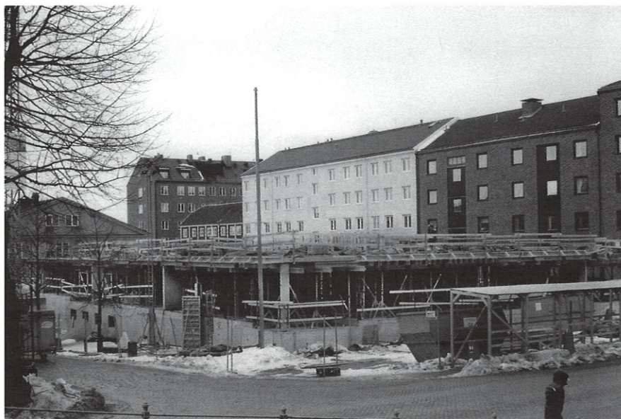
Brf Bataljonen 11 under byggnadstiden. Foto 15 februari 2006
