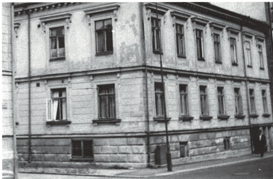
Vallgatan 20, Ficherstömska skolan. Numera rivet och ersatt av bostadshus. Bild: FGC arkiv
