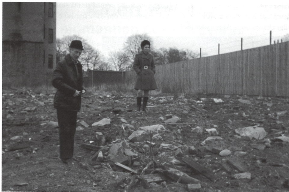
Sonen till Sigfrid Edvardsson och sonens hustru besöker tomten efter rivningen av Varvsgatan 23-25.
