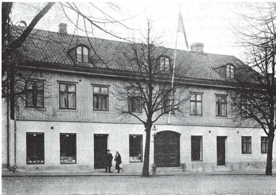
Drottninggatan nummer 43. Bilden visare fasaden mot Drottninggatan, med affärer och huvudentrén till gården.
