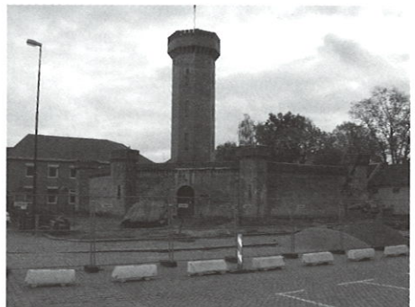
Vattenborgen, ombyggnad pågår
