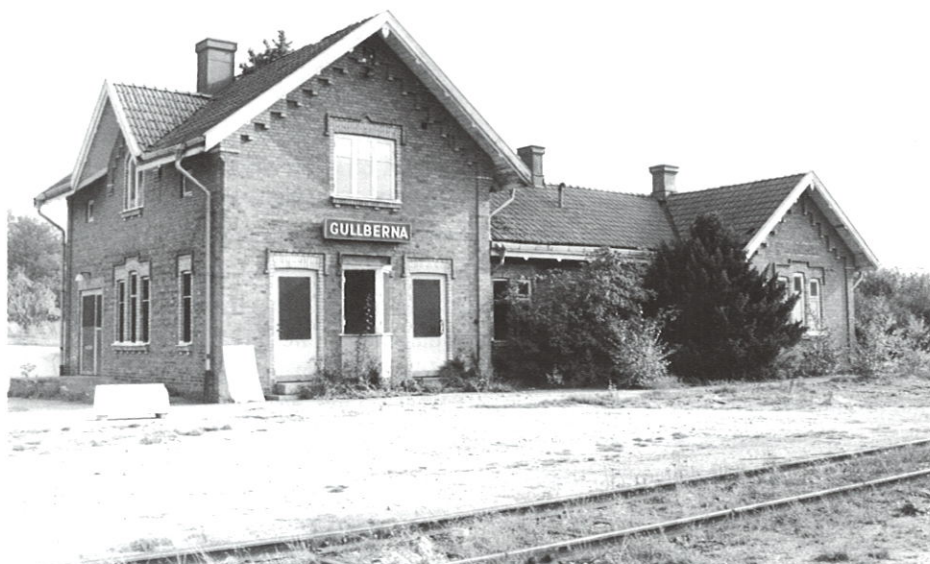
Gullberna station något år före rivning. Foto Gunnar Ekström.
