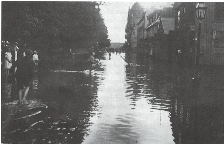
Översvämning på Norra Kungsgatan. Bilden är tagen från söder och i mitten syns bl a Brandstationen och Fribergsska huset
