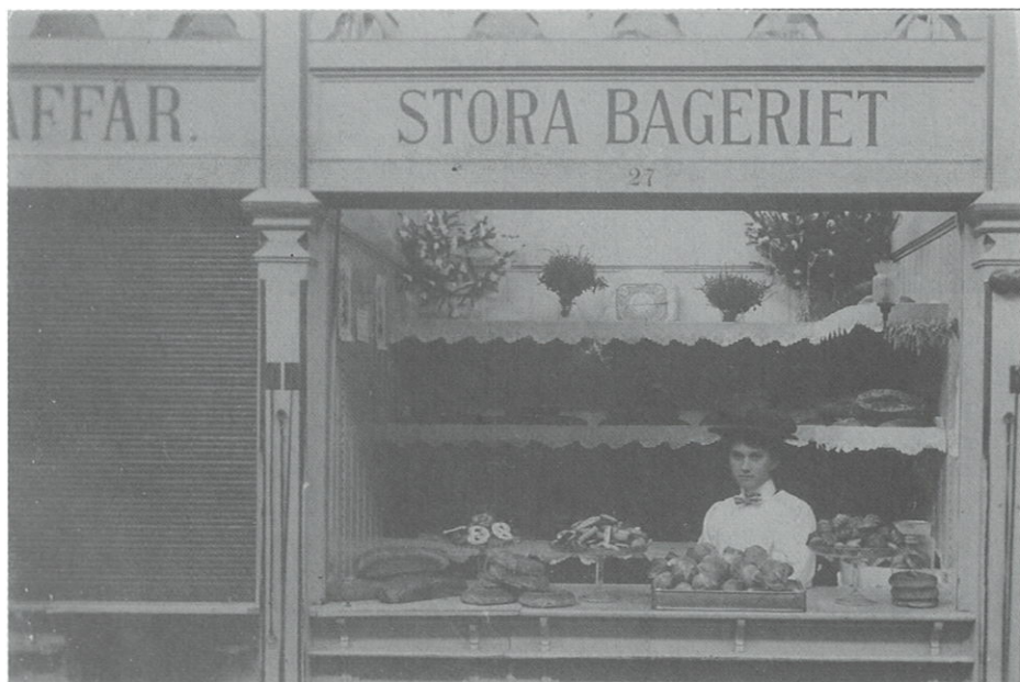
Stora Bageriet hade plats nummer 27
