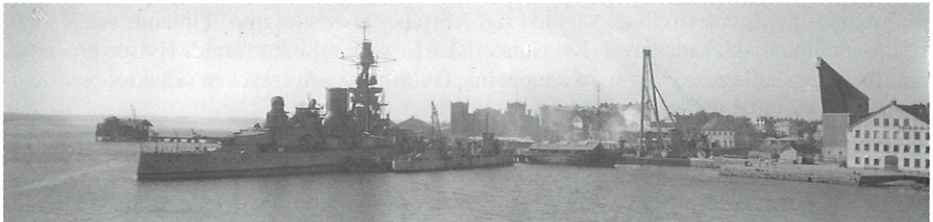
Karlskrona Örlogsvarv, mastkranen och dockorna.
