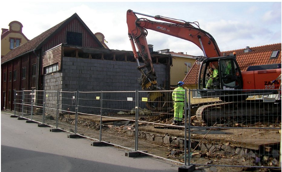
Verkställd rivning av norra hamnmagasinet
