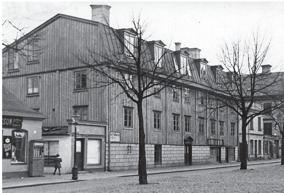
Södergrenagården Drottninggatan 50. Till höger ligger det Rubenska huset, som ersatts av verkstadsskolans elevhem. Foto Bl. museum.
